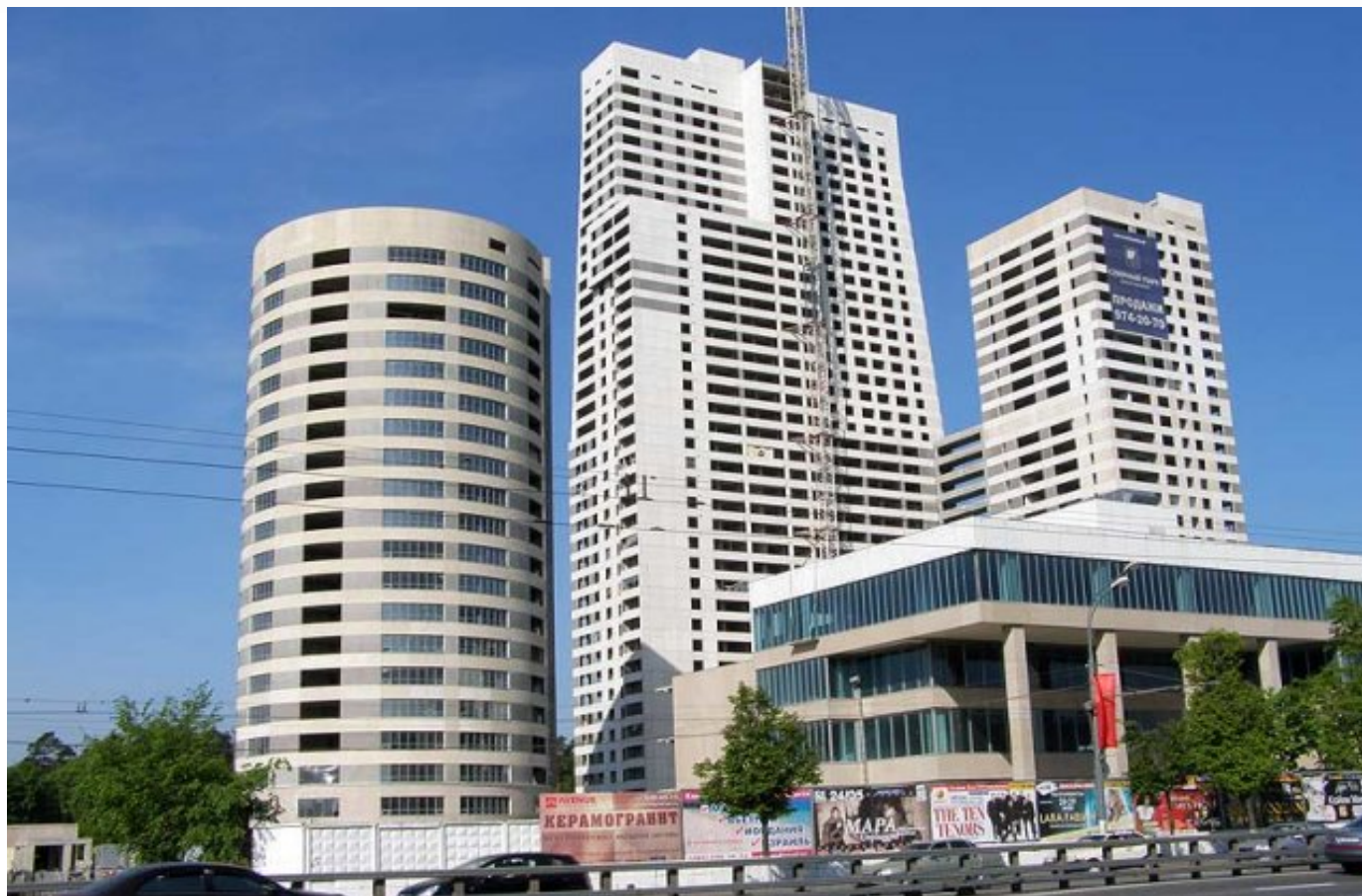
4. Жилой комплекс бизнес-класса «Северный парк» Московская обл, г. Москва, Ленинградское шоссе, 25
